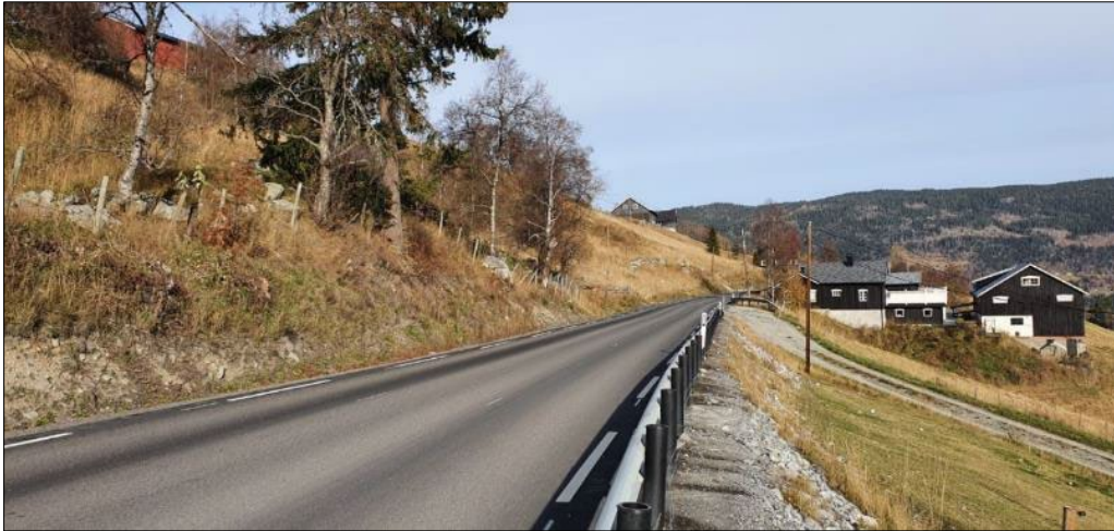
Figur 5-5 Bilde fra Kaupang som viser eksisterende situasjon. En breddeutvidelse til 9 m vil allerede medføre betydelige terrenginngrep og beslag av dyrka mark. Etablering av en separat gang- og sykkelveg vil medføre innløsning av bebyggelse, enda mer beslag av dyrka mark og større virkning på landskap.
