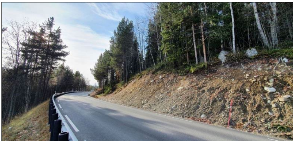
Figur 4-22 Sideterreng langs Rv. 7 ved Nørdre Kaupang, sett mot sør [befaring 18.10.2021].
